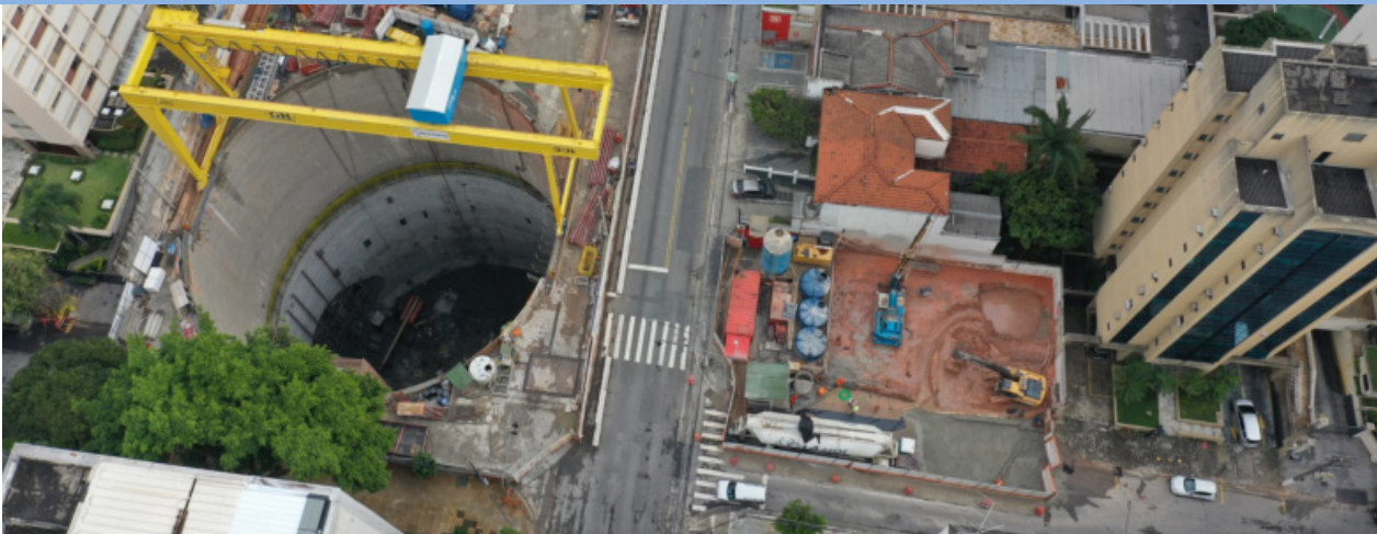
Implantação do revestimento secundário do poço principal, Estação PUC-Cardoso de Almeida. Foto: MetrôCPTM
