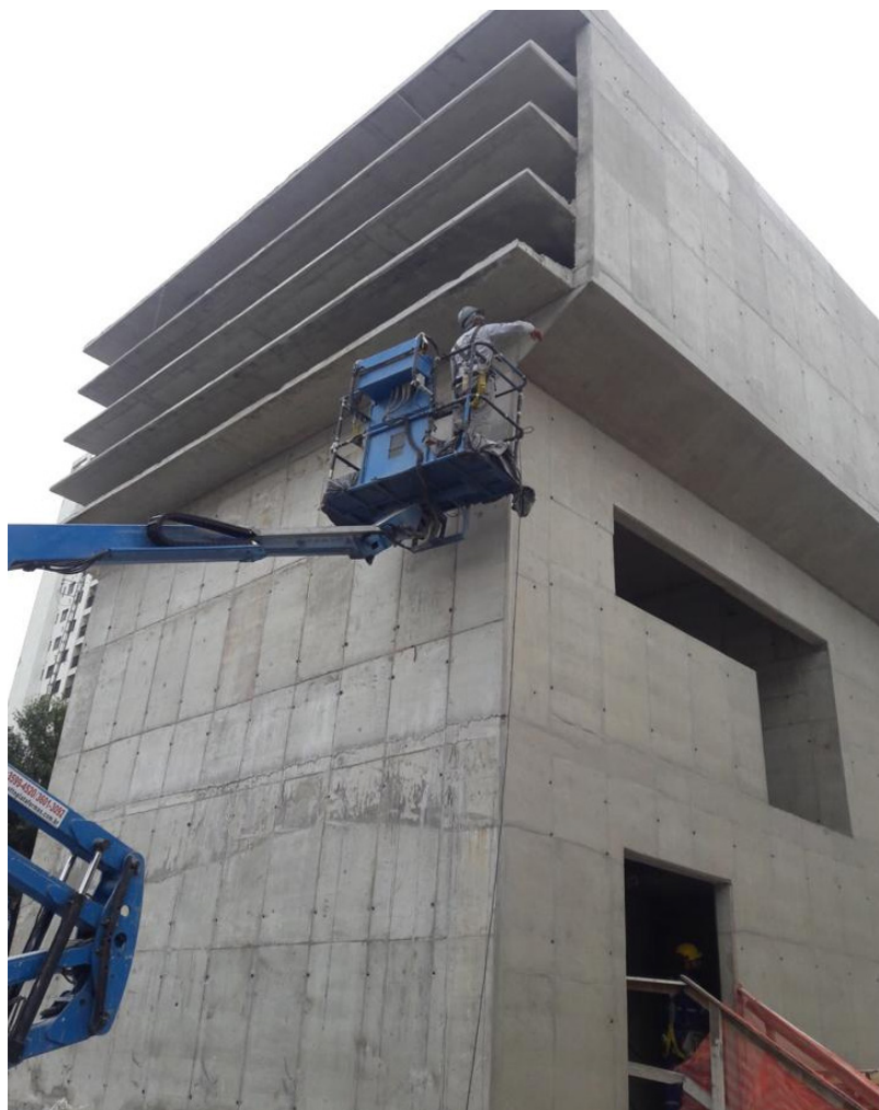
Tratamento de Concreto Aparente no Metrô - Chácara Klabin - Foto: Policroto Engenharia
