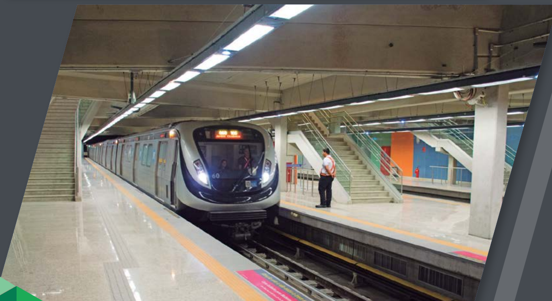
▲ Expansão Estação General Osório – Metrô RJ
