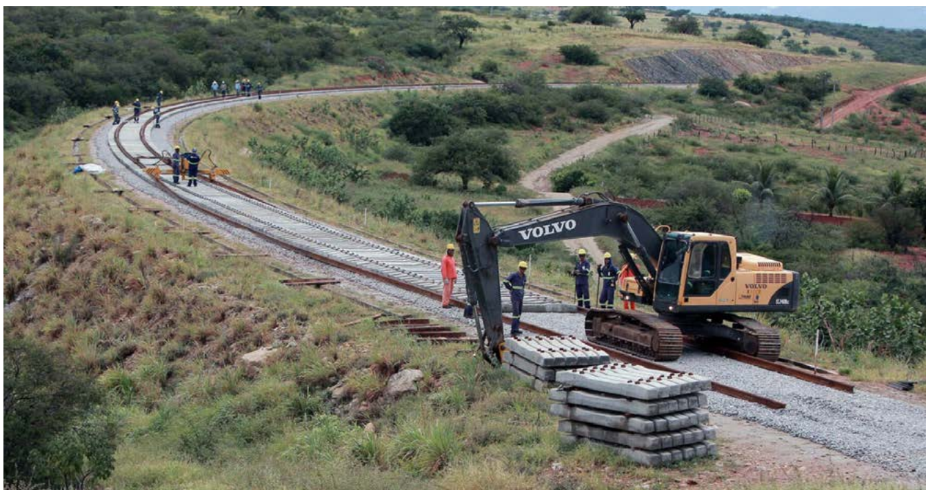
Construção da Ferrovia de Integração Oeste-Leste-FIOL
